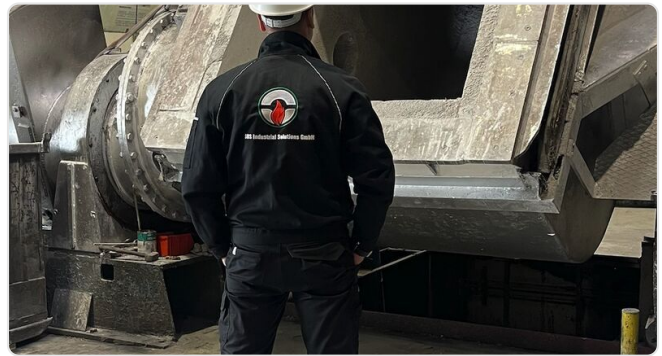
Chargierkammer nach der Instandsetzung
