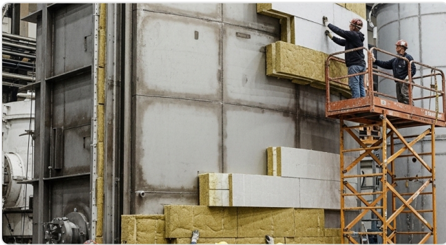
Isolierungsoptimierung am Kammerofen
