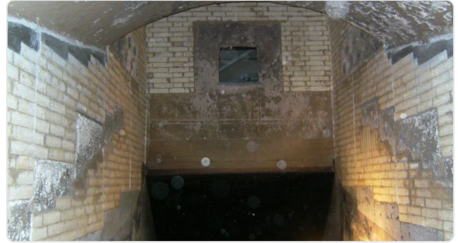
Asche und Schlacke greifen chemisch und mechanisch an
