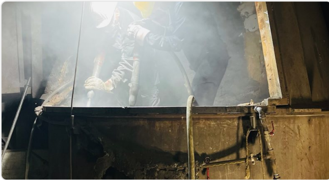
Reinigung und Ausbruch vor der Zustellung
