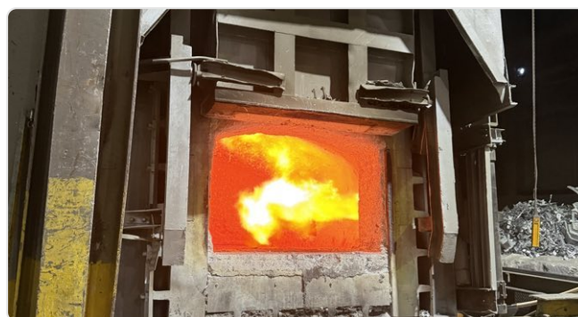
Neuzustellung im Schichtbetrieb
