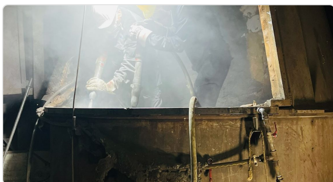
Zustellung am Kupolofen
