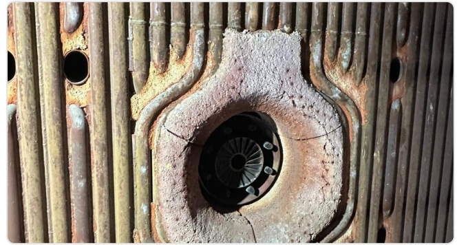
Öffnung in der Rohrwand: passgenau, Kanten ausgerundet
