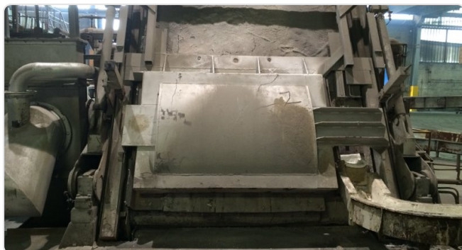
Câmpul de ancore înainte de aplicarea masei
