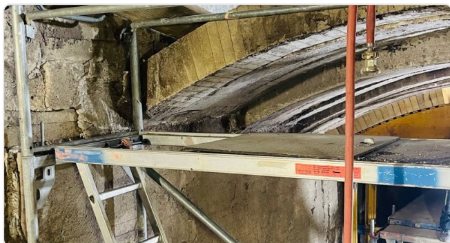
Termografia în timpul funcționării arată unde cedează zidăria
