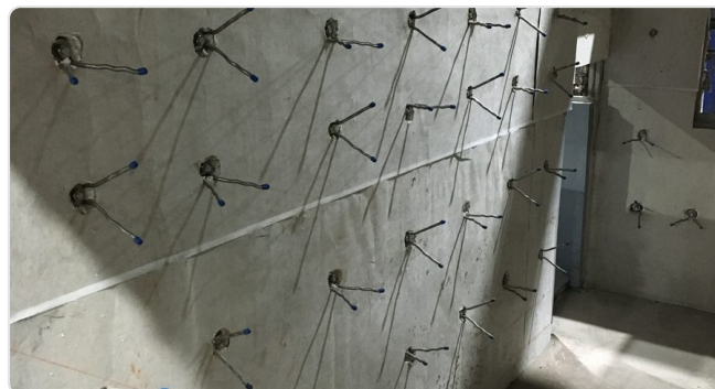
Reconstrucție: ancore în raster pe noul strat de izolație
