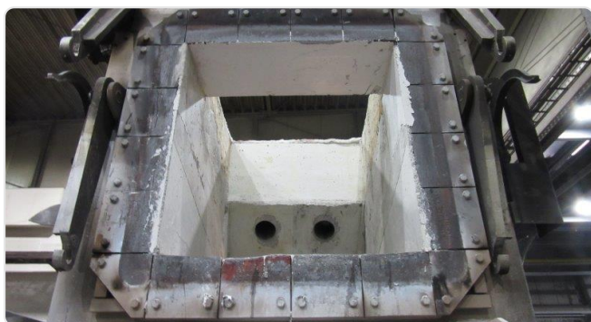
Lănci de ardere după reparație
