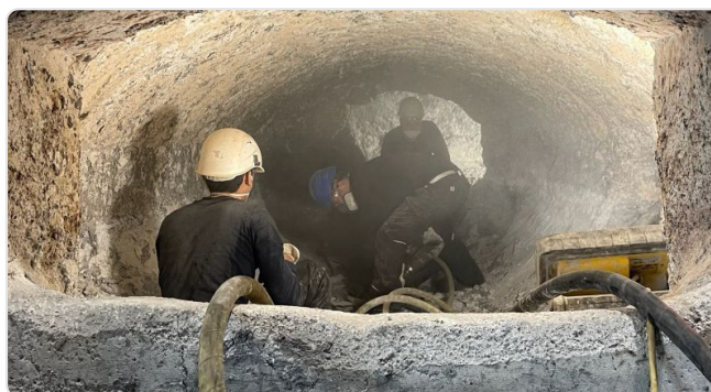
Torcretare de întreținere în timpul reviziei
