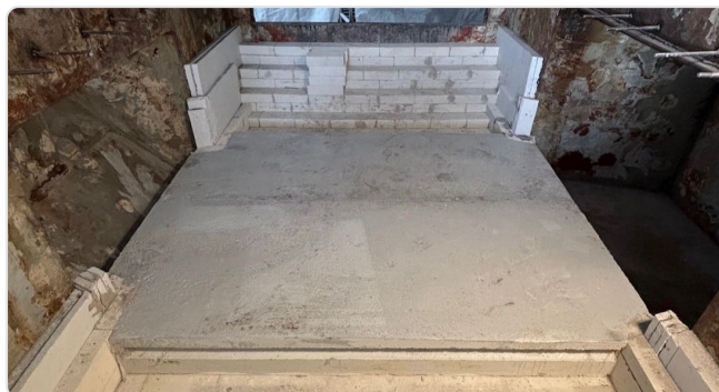
Căptușirea vetrei cu cofraj
