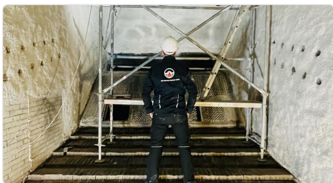
Căptușeala unei instalații de ardere a lemnului
