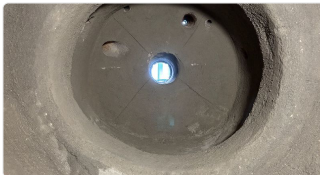
Rost de dilatare umplut corect cu saltea de fibră
