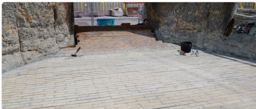
Zonă a cuptorului proaspăt căptușită înainte de încălzirea controlată
