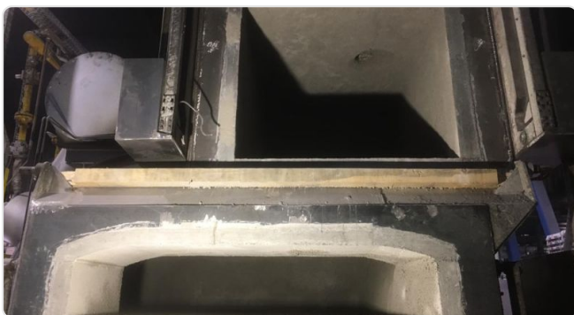
Revizie completă a unui cuptor de topire a aluminiului
