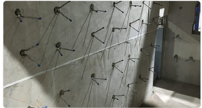
Neuaufbau: Anker im Raster auf neuer Dämmlage
