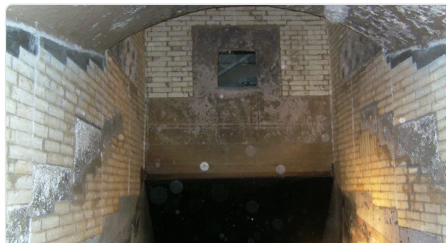
Cinzas e escória atacam química e mecanicamente
