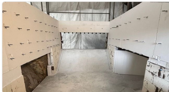
Ancoragem no revestimento da soleira
