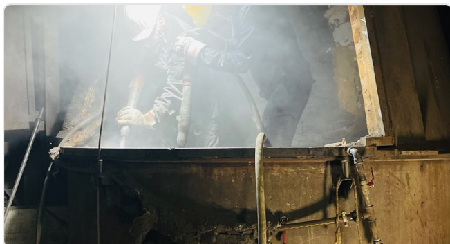
Limpeza e demolição antes do revestimento
