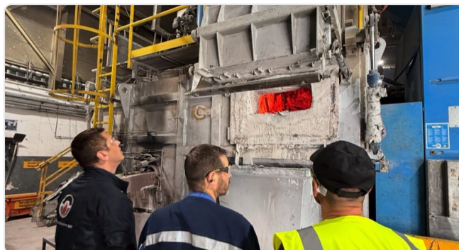
Diagnóstico durante a paragem, onde a curva revelou anomalias
