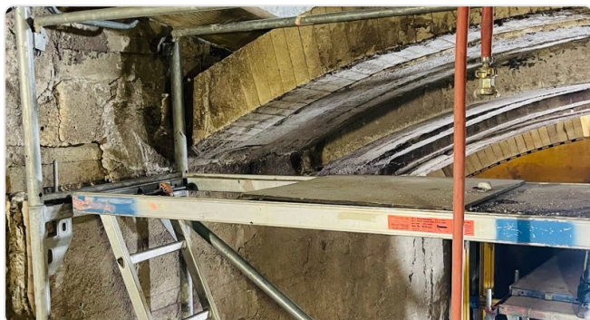
A termografia com a instalação em funcionamento mostra onde a alvenaria cede
