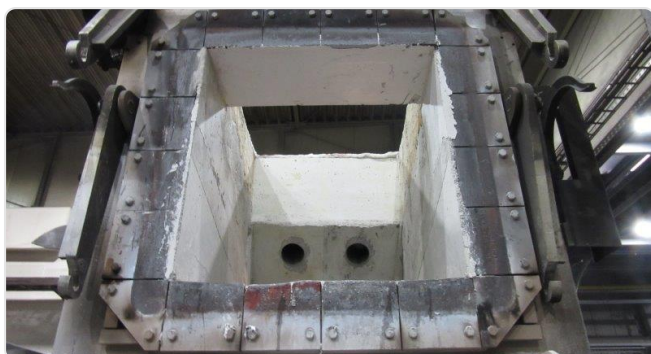
Lanças de queimador após a reparação
