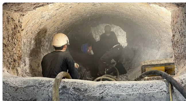
Projeção de manutenção na paragem geral
