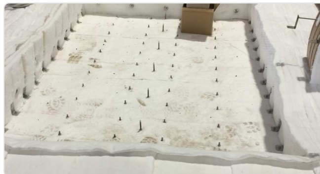
Malha de ancoragens no quadro da tampa antes do vazamento
