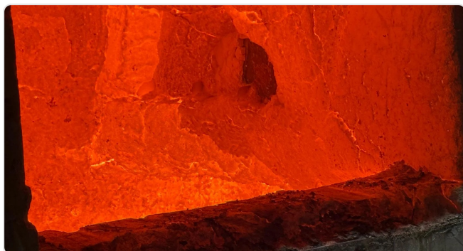
Reparação de emergência num forno de alumínio
