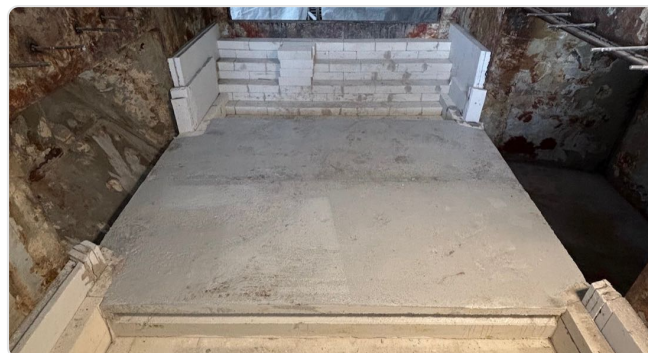
Revestimento da soleira com cofragem
