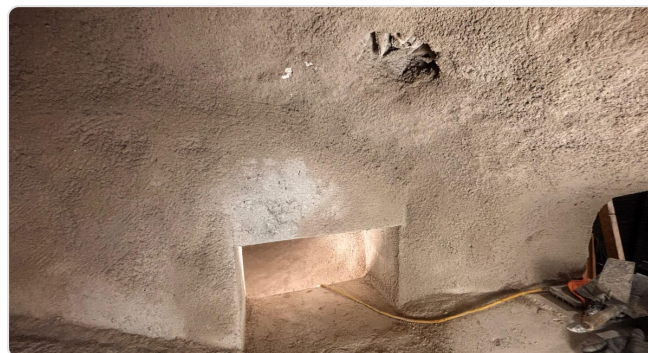
Parede e soleira monolíticas na zona de passagem da ferramenta
