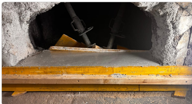
Abertura de carga: nova soleira sobre cofragem, contorno demolido em ângulo reto
