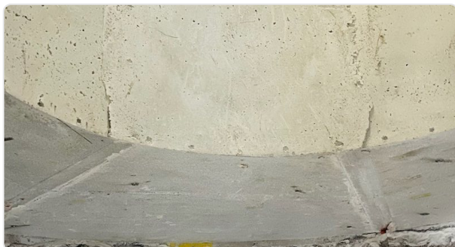
Revestimento monolítico concluído, com ligações bem executadas
