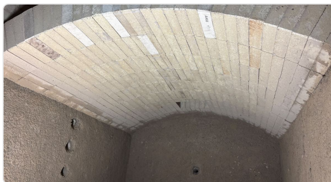
Nova abóbada na câmara de combustão
