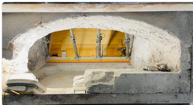
Abertura do forno limpa antes da reconstrução
