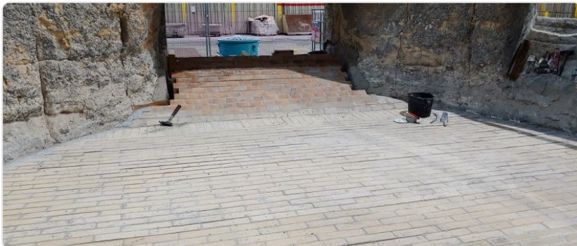
Zona do forno acabada de revestir antes do aquecimento controlado
