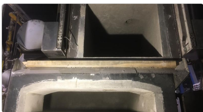
Revisão completa de um forno de fusão de alumínio
