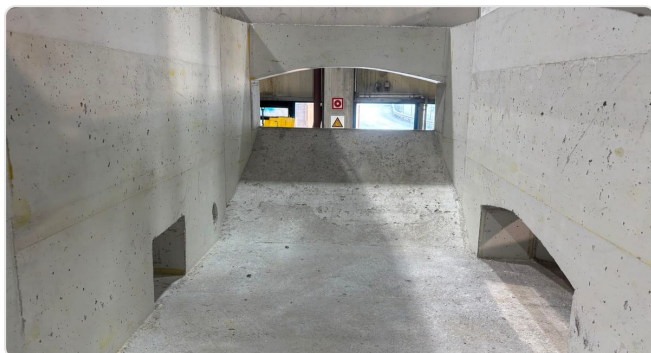
Câmara do forno com novo revestimento antes do primeiro aquecimento
