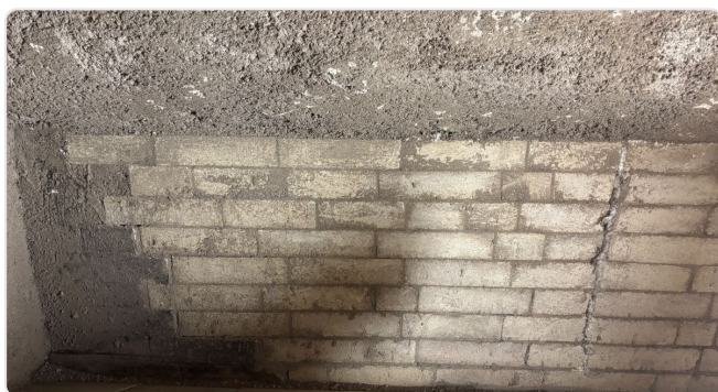
Transição dentada em degraus; à direita, a junta de dilatação
