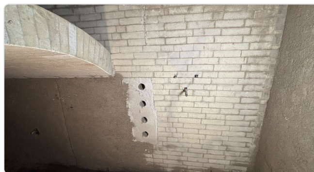
Aberturas de ar secundário colocadas durante a instalação
