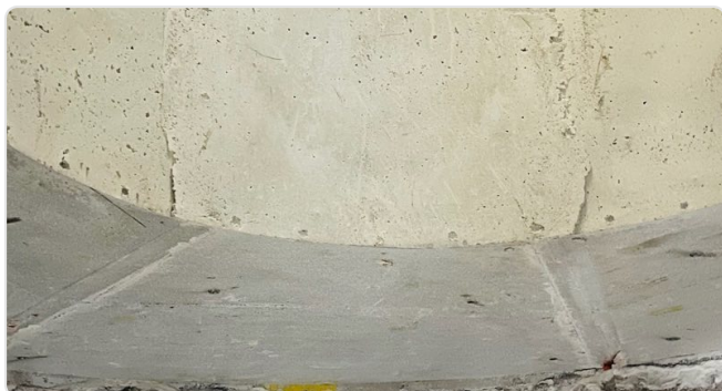
Gotowe wyłożenie monolityczne z czystymi połączeniami
