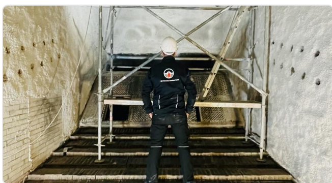
Wyłożenie instalacji spalania drewna
