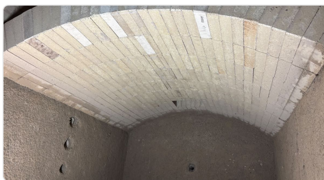
Nowe sklepienie w komorze spalania
