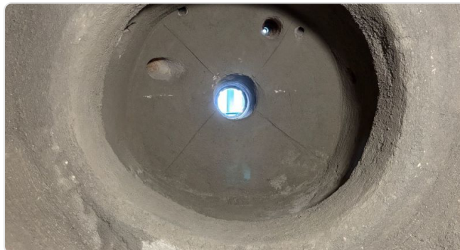
Szczelina dylatacyjna fachowo wypełniona matą włóknistą
