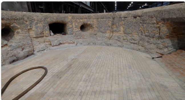
Najmniej rzucająca się w oczy przyczyna uszkodzeń wyłożenia
