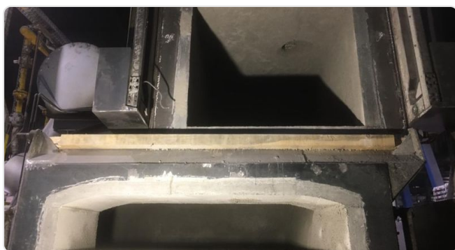
Kompletny remont pieca do topienia aluminium
