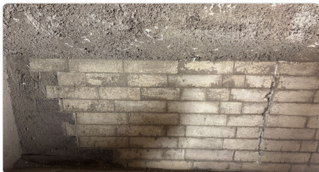
Schodkowo przewiązane przejście, po prawej szczelina dylatacyjna
