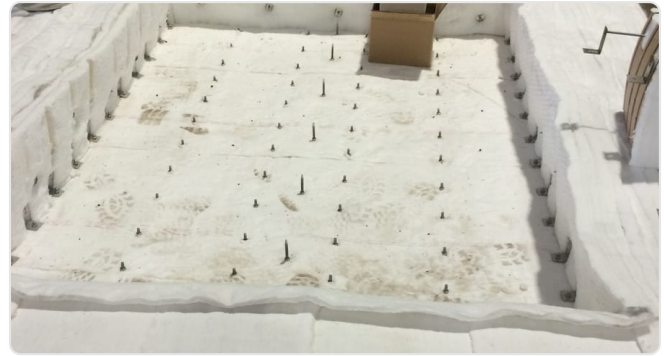
Ankerraster im Deckelrahmen vor dem Guss
