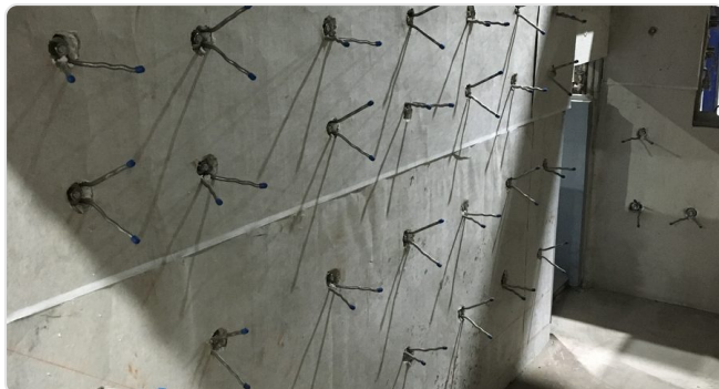
Nieuwe opbouw: ankers in een raster op een nieuwe isolatielaag
