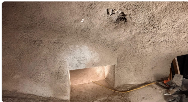
Monolithische wand en bodem ter hoogte van de gereedschapsbaan
