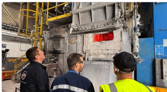
Inspectie tijdens stilstand
