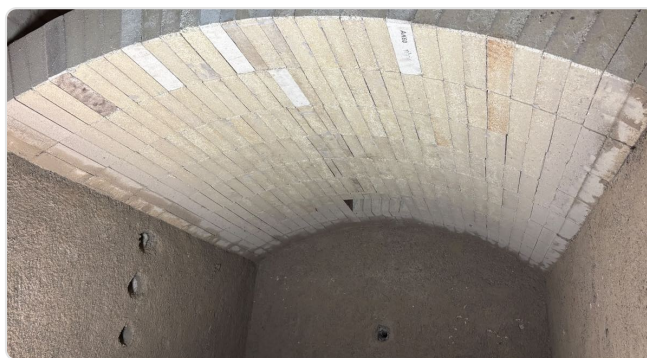
Nieuw gewelf in de verbrandingskamer
