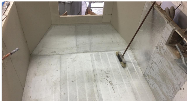
Bekleding met geprefabriceerde vormstukken
