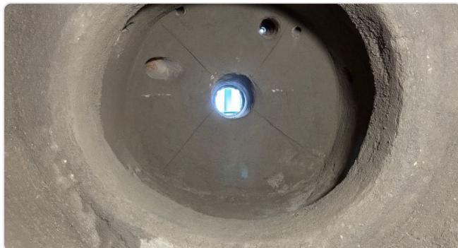
Dilatatievoeg vakkundig gevuld met vezelmat
