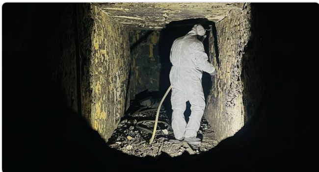
Blik door het mangat: één ingang voor mens, materiaal en terugweg
