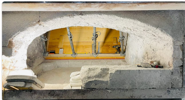
Gereinigde ovenopening vóór de nieuwe opbouw
