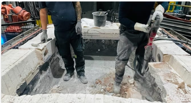
Uitbraak aan de oven terwijl de hal in bedrijf blijft
