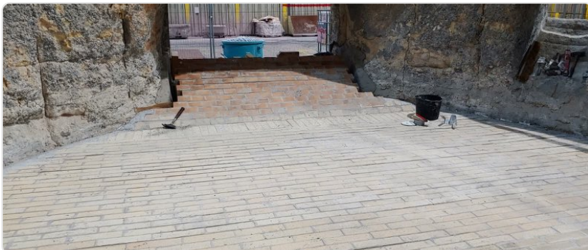
Pas beklede ovenzone vóór het gecontroleerde opstoken
