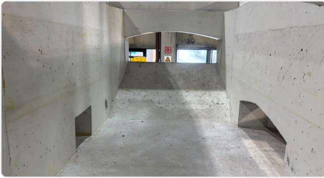
Opnieuw beklede ovenruimte vóór het eerste opstoken
