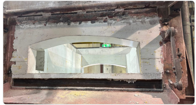
Ovenfront: opening en deur passen bij de nieuwe geometrie
