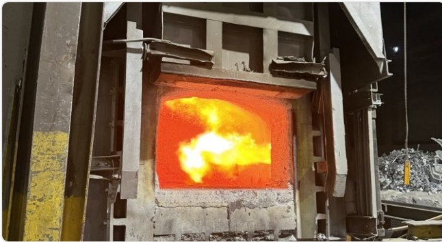
Neuzustellung im Schichtbetrieb
