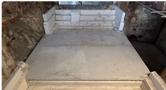
Bodenzustellung mit Schalung
